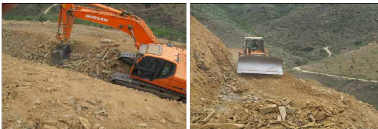
Operações mecânicas de desagregação da rocha e aprofundamento do solo e armação do terreno em socacos no Douro. Foto AM
