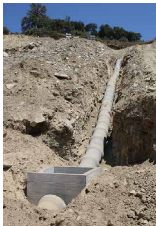
Estruturas de drenagem principal: modelo tradicional de organização da drenagem superficial em paisagem construída (à esquerda); tubagem enterrada em vinha em fase de instalação (à direita)
